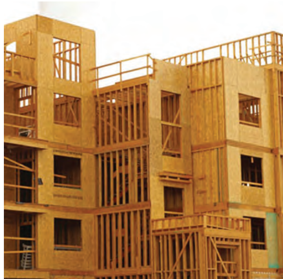
Figure 42—Stud wall framing
